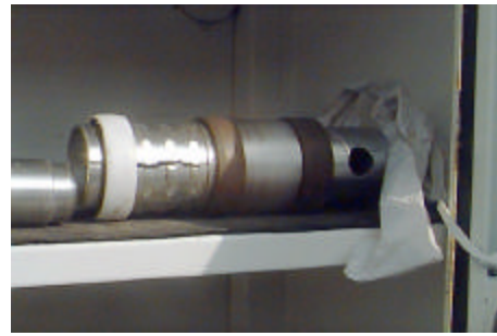
Foto 1: Se observa la fisura en donde se dañó la barra de mando (casquillo de la parte superior).
