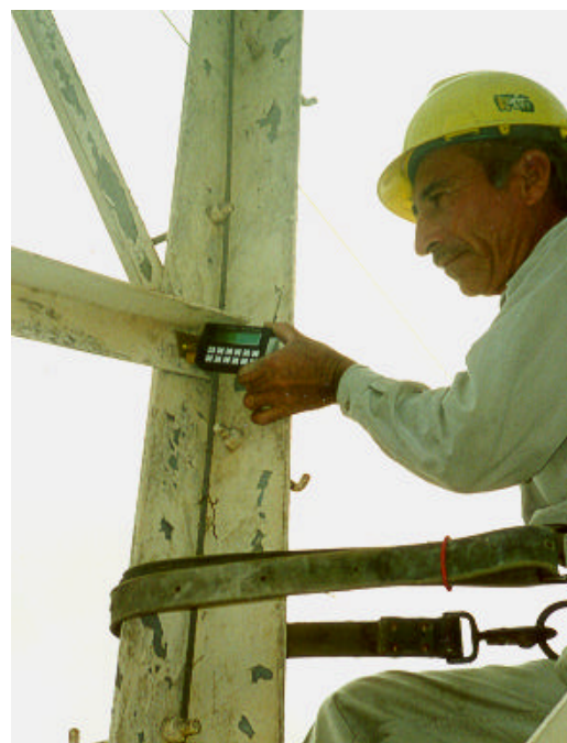
Liniero tocando dispositivo de memoria con la microcomputadora "Colector", para identificar la torre y proceder a realizar la inspección.
